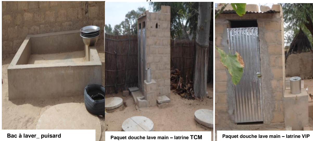
Photos N°05: Types de latrines réalisées
